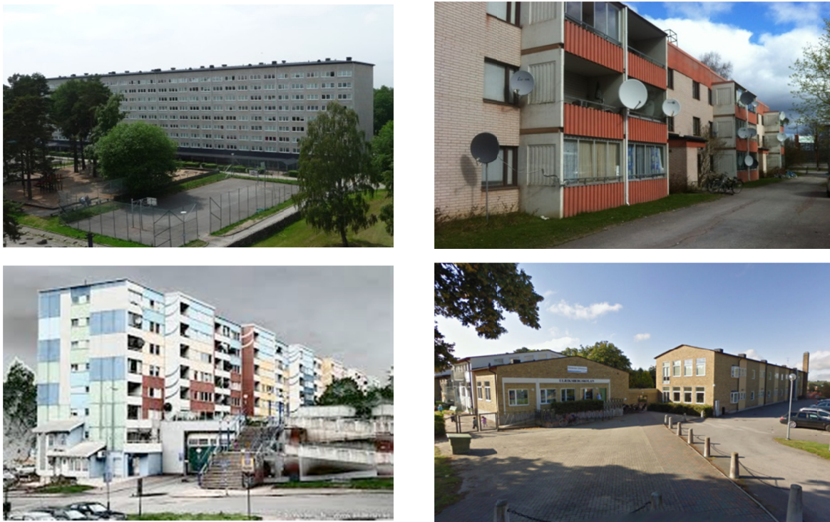
Figure 1. The four SIREn Living Labs: Top-left: Hammarkullen, Gothenburg. Top-right: Tjärna ängar, Borlänge. Bottom-left: Siriusgatan, Gothenburg. Bottom-right: The Ulriksberg School, Växjö
